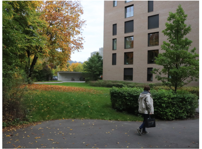
Unter der Grünfläche befinden sich die Einstellhalle und einer der Eisspeicher. Letzterer besteht aus einer zylinderförmigen Betonwanne mit einem Durchmesser von 11,4 m. Die Füllhöhe beträgt 4,1 m. Foto: B. Vogel
