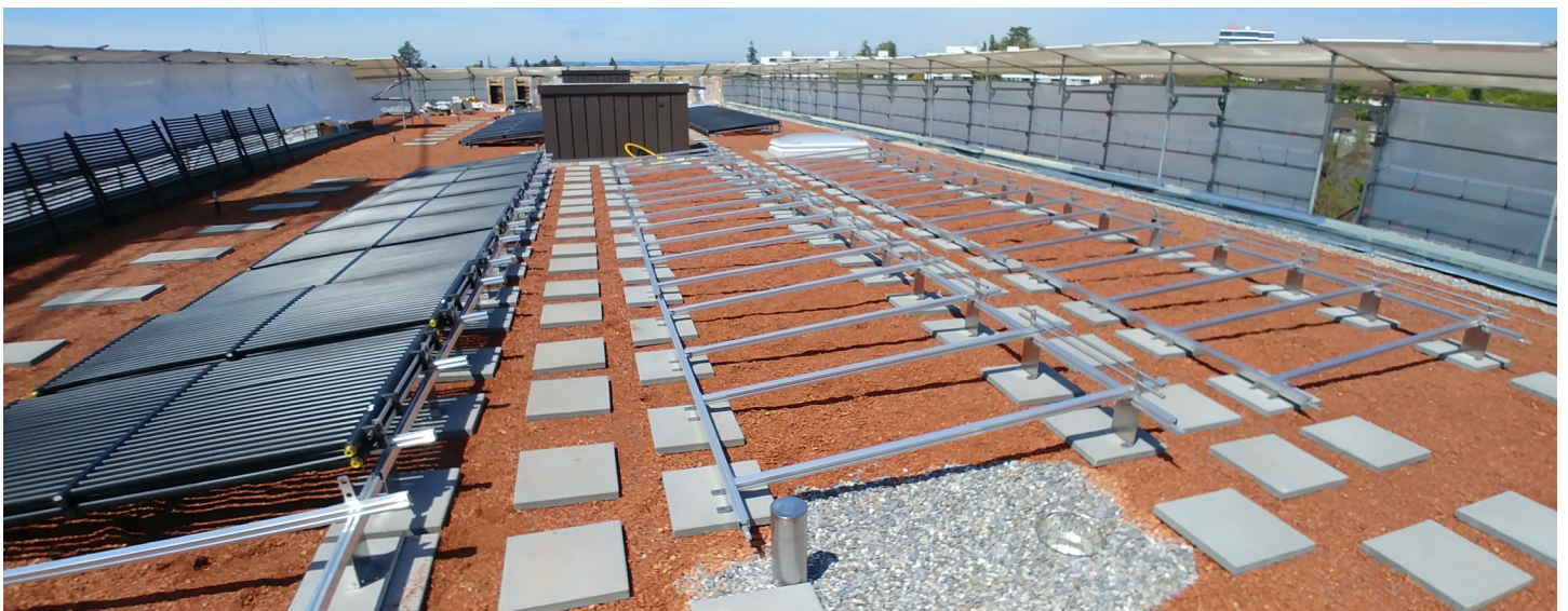
Solkollektoren der Überbauung Weltpostpark während der Montage. Foto: eicher+pauli
