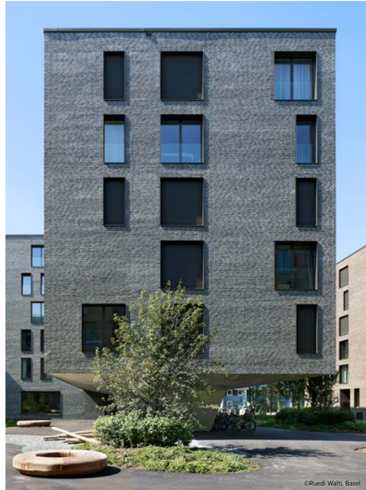
Die markanten, sechsgeschossigen Wohnbauten des Weltpostparks
