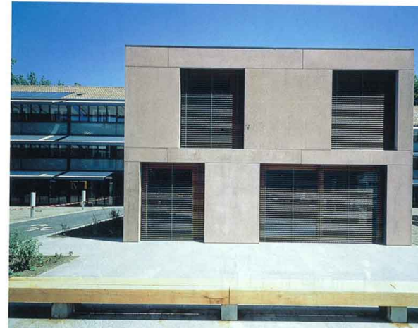
1 Fassade zur Rheinfeldstrasse (Fotos: Ruedi Walti)
