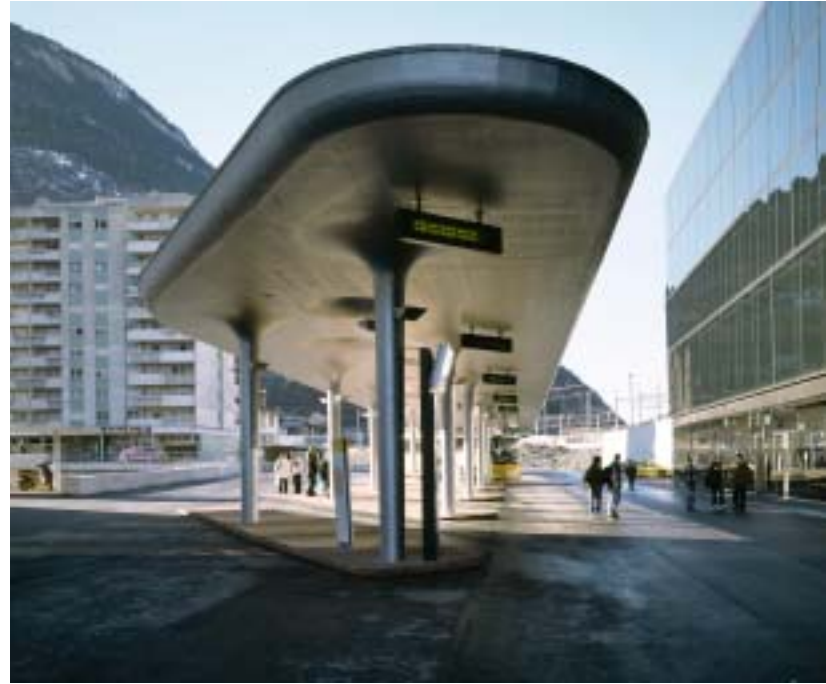
Der scharf geschnittene Körper des neuen Bahnhofgebäudes kontrastiert mit den weichen Formen des Daches über der Busvorfahrt.
