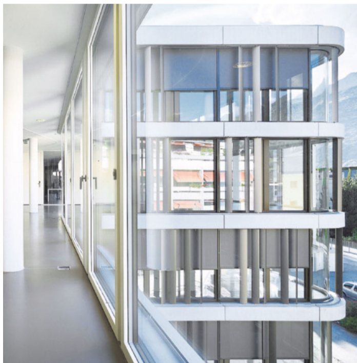
Hell. Der Neubau überzeugt mit seiner Architektur. FOTO ZVG
