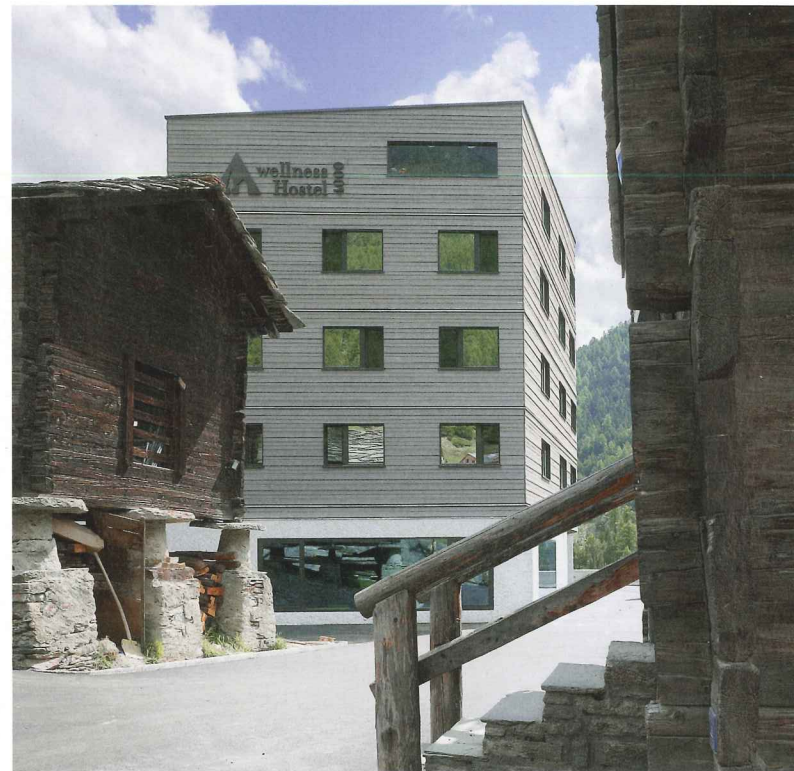
Zwei Arten Speicher: die historischen Stadel und die neue Herberge.
