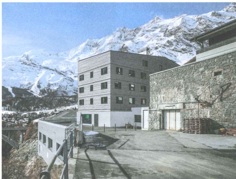
Die Holzfassade steht auf einem schlichten Sockel und greift oben schräg gegen die Berge.
