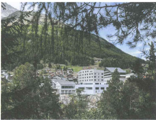
Der Neubau steht am Hang über dem Wellnesssockel, der in die Felsen gebaut ist.
