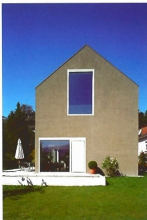
Nach außen erscheint das Doppelhaus als präzise geschnittenes Volumen.
