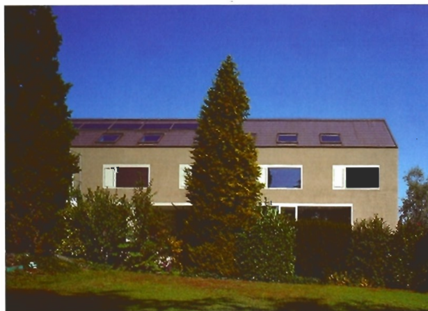
Die grafiformaligen Holzfenster sind bündig in die verputzte Fassade eingefügt.
